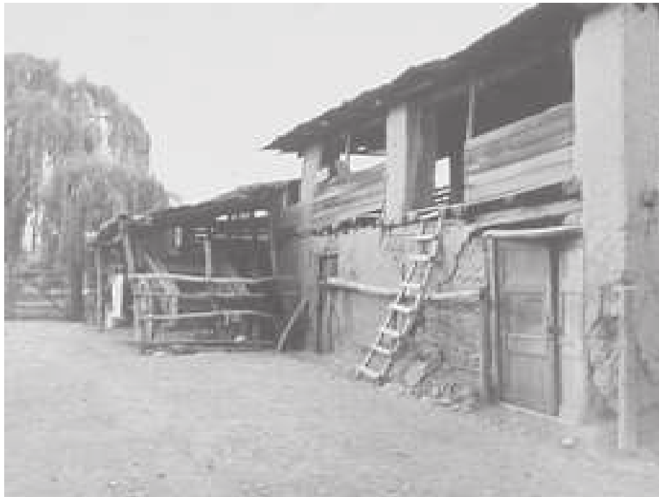
Doblado que aun subsiste, se puede apreciar las características propias de este tipo de construcción.
