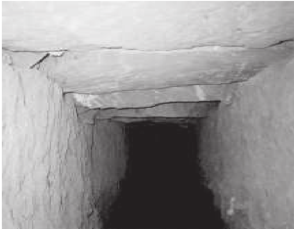
Túnel comunicacional en predio agrícola. Las paredes y el piso son de tierra. El cielo está formado por lajones de piedra de cerro.
